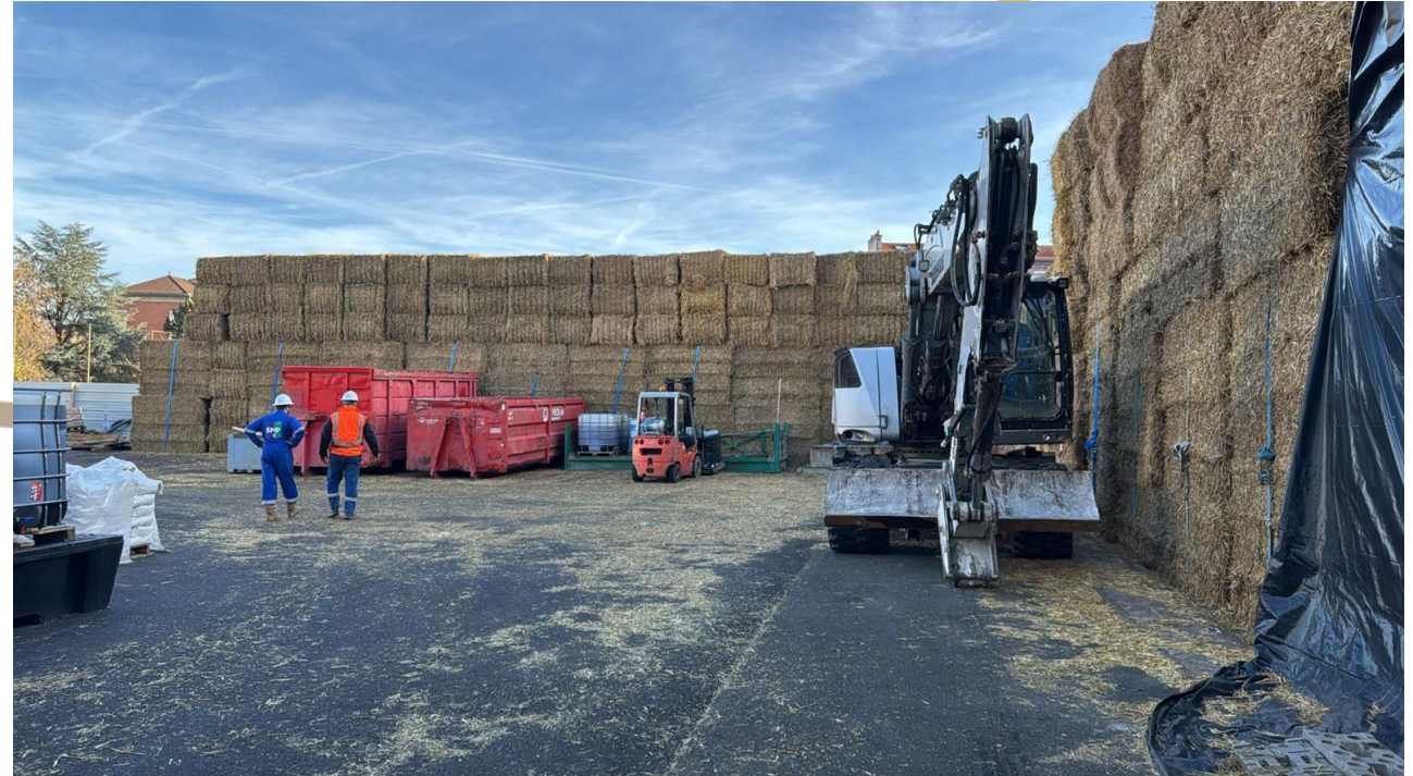
Installation des murs de paille acoustiques de 6m de haut & 4m d'épaisseur
