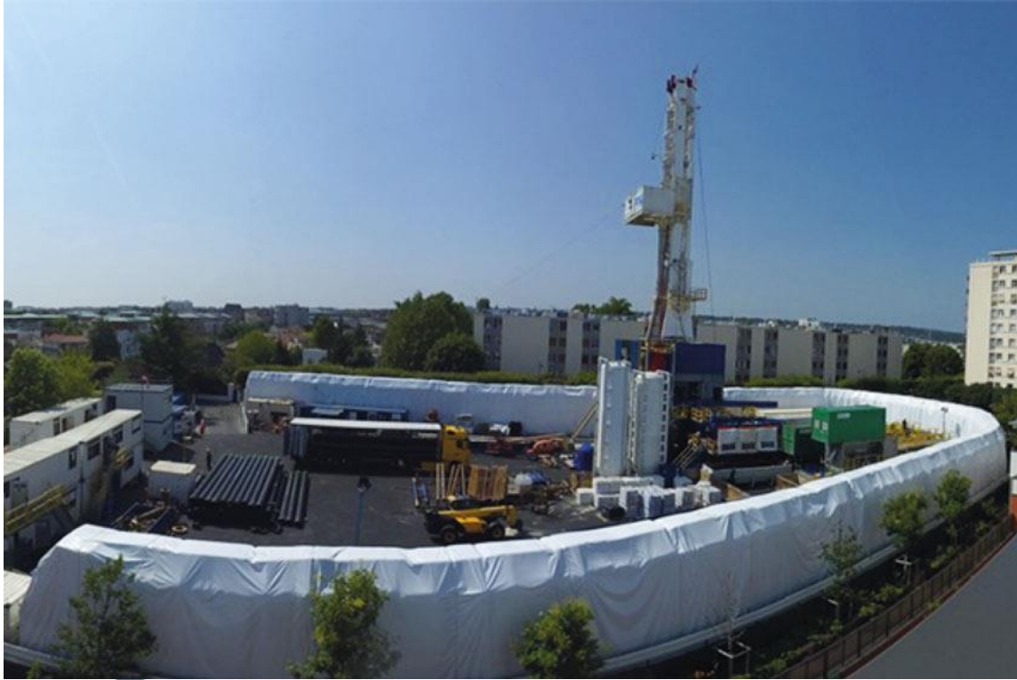
Exemple chantier de forage
