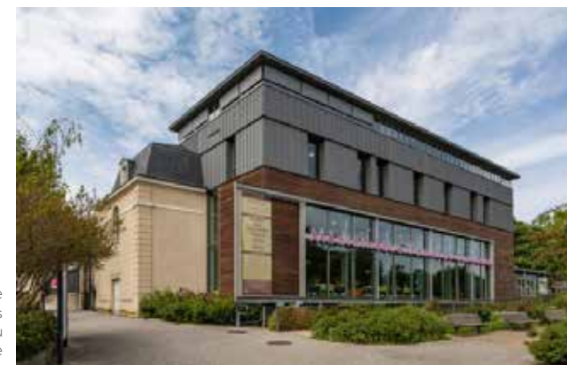
Médiathèque de Fontenay-aux-Roses 6, place du Château Sainte-Barbe
