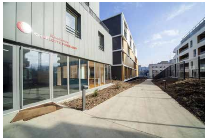
Suite au désordre constaté et déclaré en 2020, chute de bardage, la rénovation partielle a été entreprise en juin et finalisée en juillet 2024.
