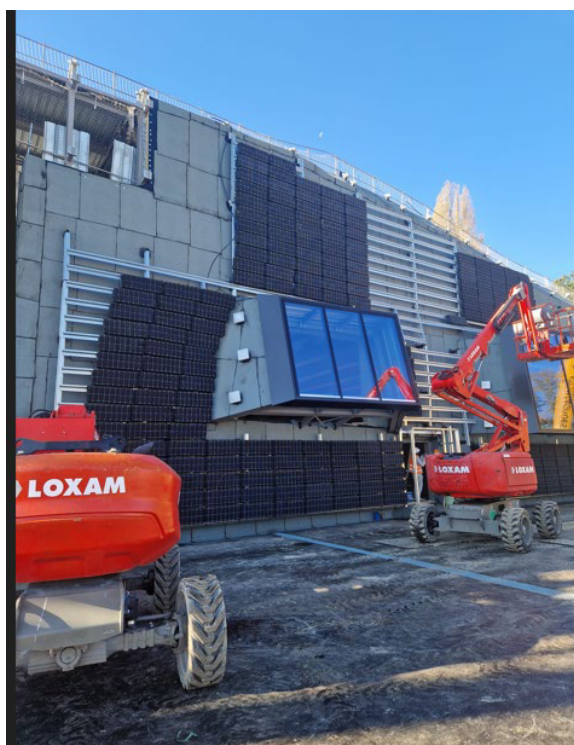
Réalisation de la façade végétalisée
