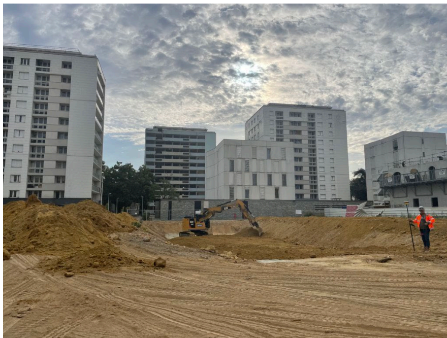
Travaux de remblais après démolition du bâtiment A en juillet 2023.
