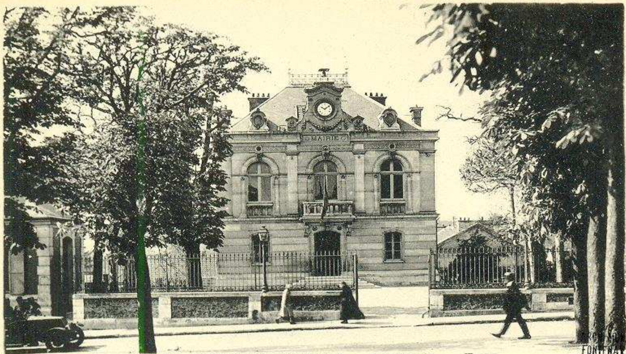
5801. FONTENAY-AUX-ROSES — La Mairie
