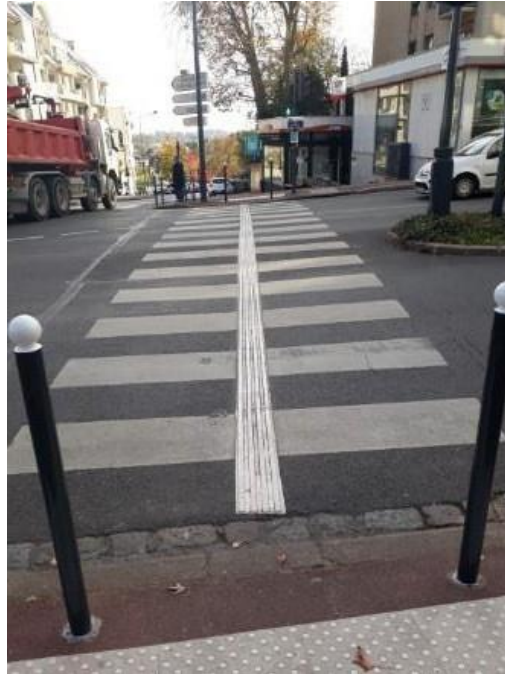
Dalle podotactile au carrefour rue BOUCICAUD/rue Antoine PETIT/ avenue Jeanne et Maurice DOLIVET et bande de guidage.
