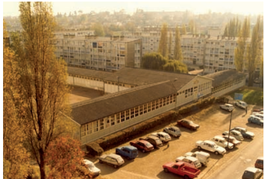
Le centre aéré dans les années 1970
