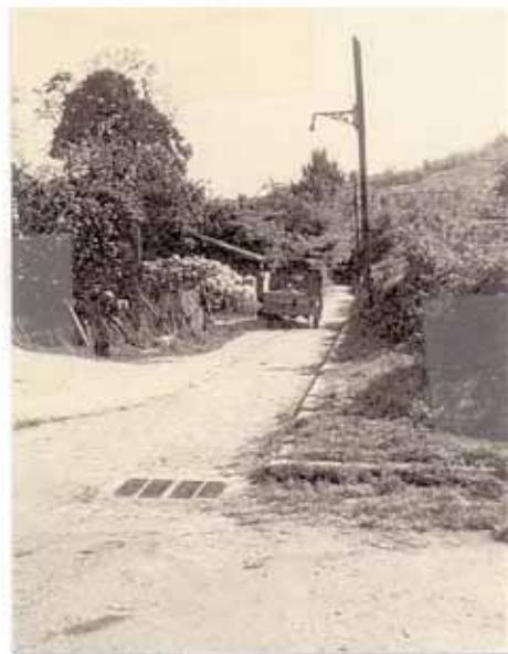
Le sentier de la Fosse Bazin après 1945 (AM Fontenay)
