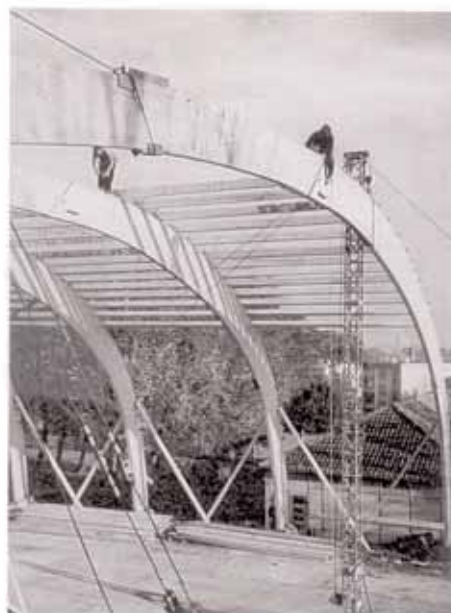
Le gymnase du Parc en cours de construction (décembre 1968).
