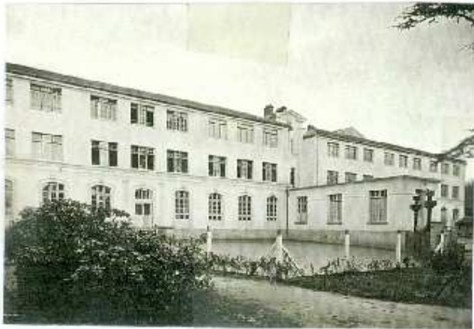
Le nouveau groupe scolaire (vers 1928).
