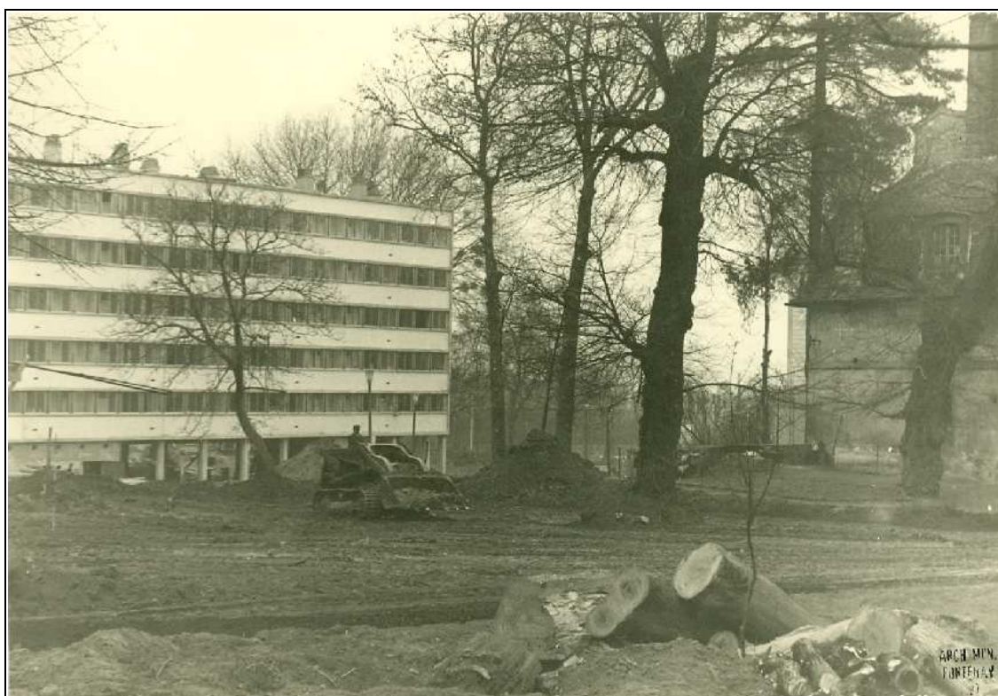
Travaux dans le parc. (sans date) AM FaR
