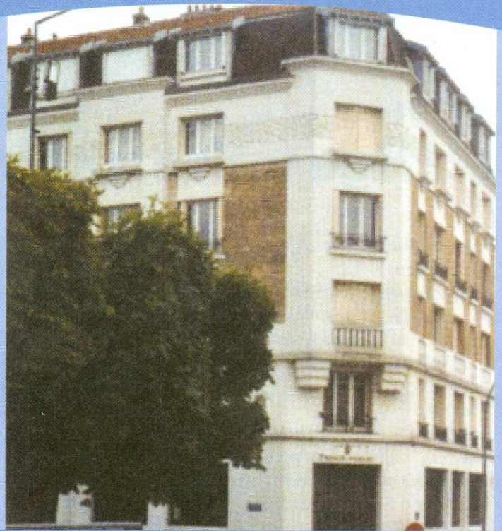
En 2004, seul un ravalement a légèrement modifié l'aspect de la façade.
