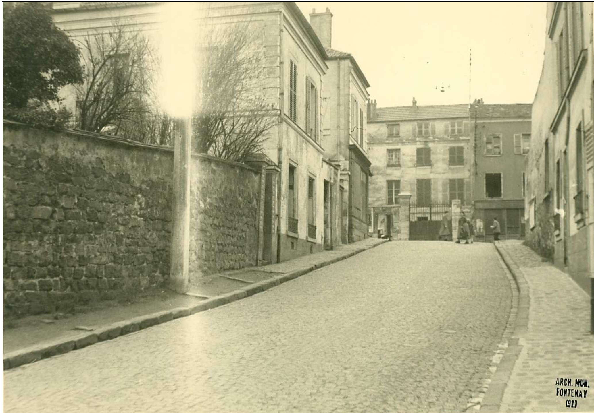
7 Fi PETI 103 [au fond, la rue Boucicaud : l'avenue de Paris, future avenue Jeanne et Maurice Dolivet, n'est pas encore percée ]
